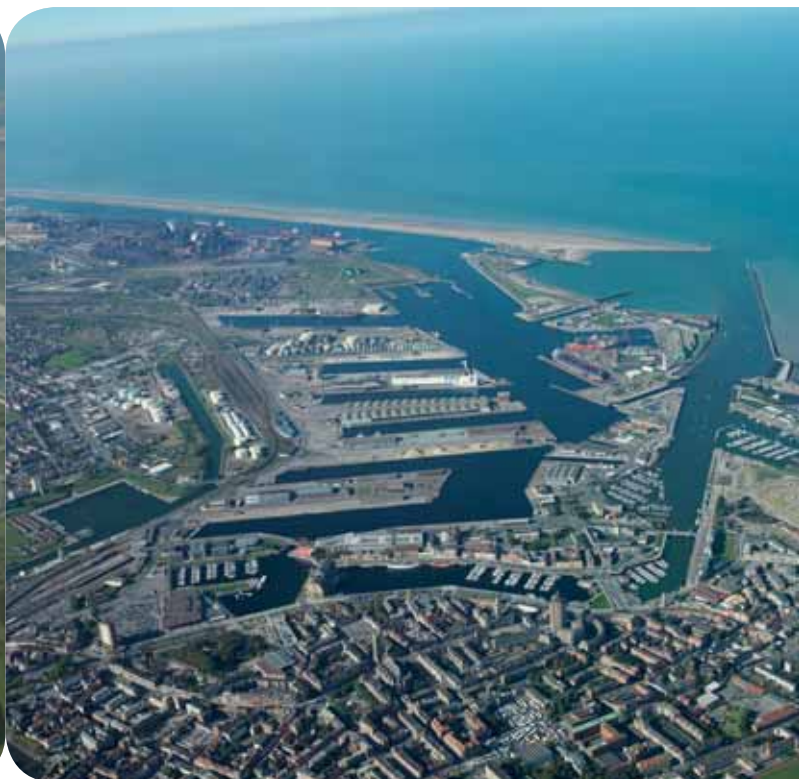
Port Est de Dunkerque
