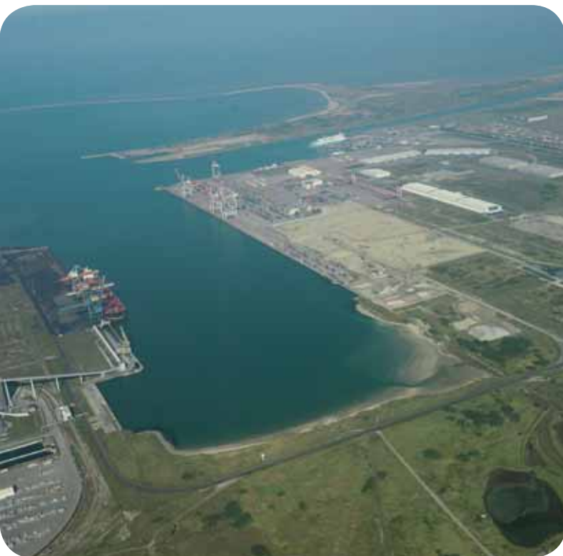
Port Ouest de Dunkerque
