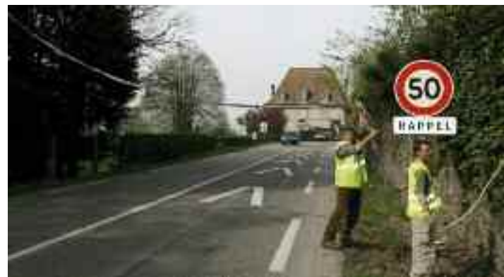
Aménagement d'une passerelle à écureuils sur la D520 à l'Agnelas, Voiron (38).
