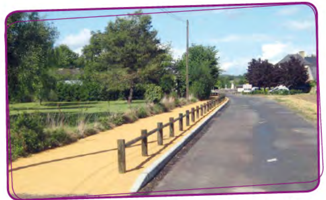
Pontigné : La voie douce entre le lotissement du Clos des Mégalithes au parking de la mairie est terminée !
