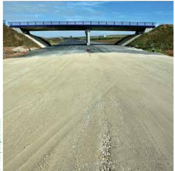
La construction d'infrastructures routières près d'Angoulême.
