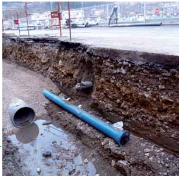
L'ouverture d'une tranchée dans un sol urbain pour la construction de réseaux.
