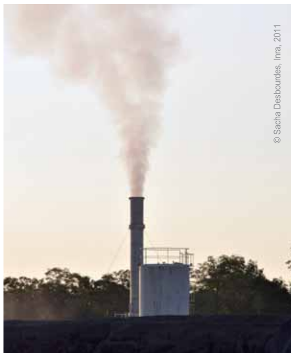
Usine de fabrication d'enrobés.
