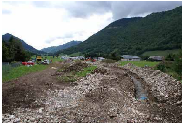
Vue du commencement des travaux du lotissement
