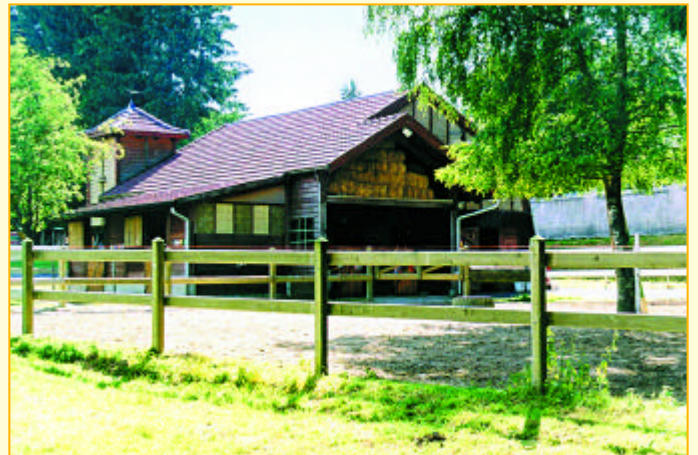
Le Chambon-sur-Lignon (Haute-Loire). Manège construction bois, constructeur Bâtimob.
