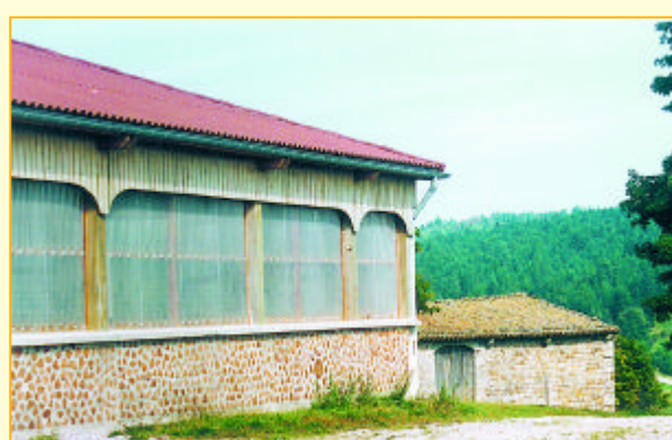
Le bois cordé s'harmonise avec les murs de pierre voisins. La forme de la voûte de la porte de grange traditionnelle est reprise dans le bardage bois de la façade sud de la chèvrerie.
