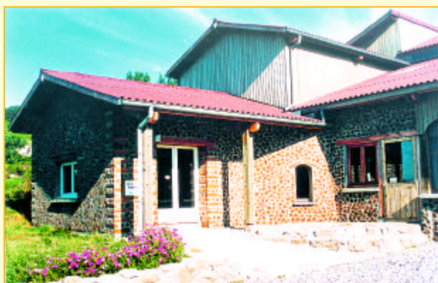
Espace d'accueil du public : parking, entrée fromagerie et salle de traite. Le bois cordé se marie aux dalles de granit.
