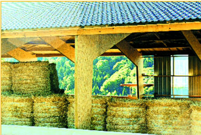
Les Terres Blanches, Le Monestier sur Gazeilles (Haute-Loire). Bâtiment pour vaches laitières, constructeur Chanal Delabre.
