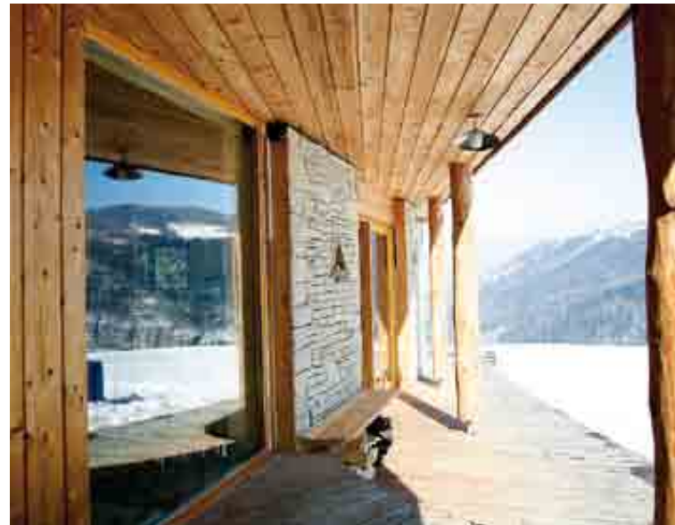
Un espace protégé sous le porte-à-faux de l'étage. Il permet une circulation a brisée et sèche l'hiver vers la buanderie et la réserve de bois.
