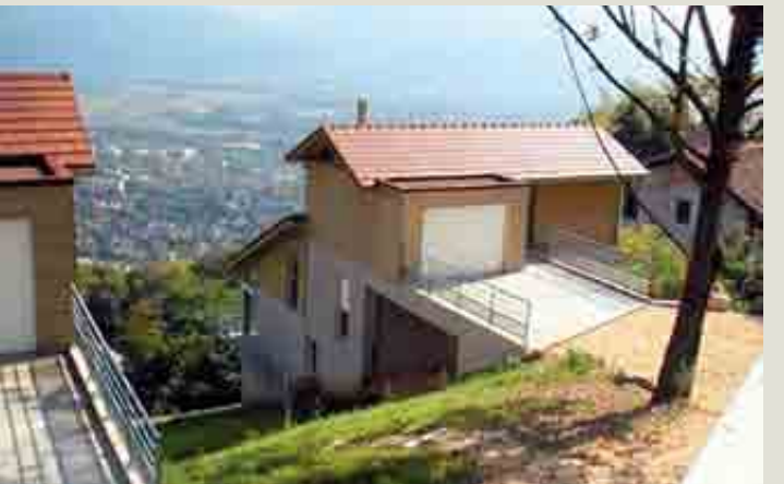
Accès par terrasses et passerelles.
