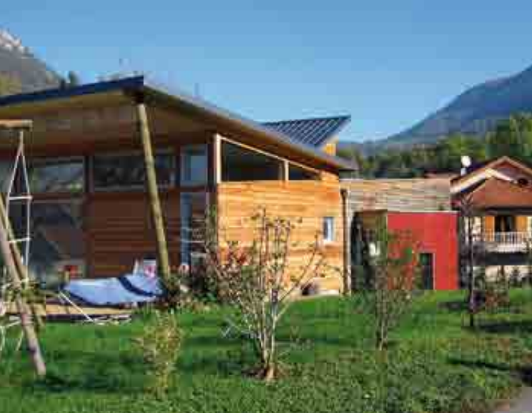
Une dépassée de toiture bien conçue permet de réguler l'ensoleillement en fonction des saisons.
