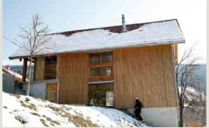
Accès de plain-pied aux différents niveaux de la construction.
