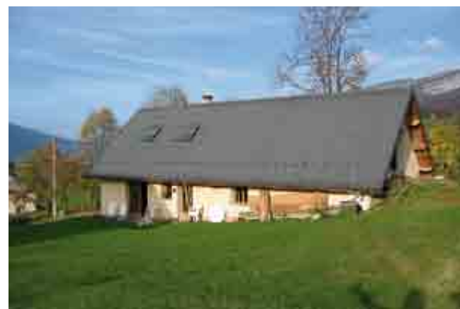
Encastree dans le sol, organisée autour d'un volume compact et protégée par l'espace du garage au nord, cette maison utilise des orientations qui lui permettent de limiter les déperditions thermiques.
