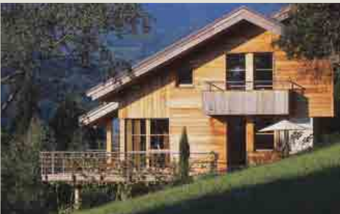
Stationnement et garage en partie basse Accès de plain-pied aux principaux niveaux de la construction par une construction des niveaux en "cascade".
