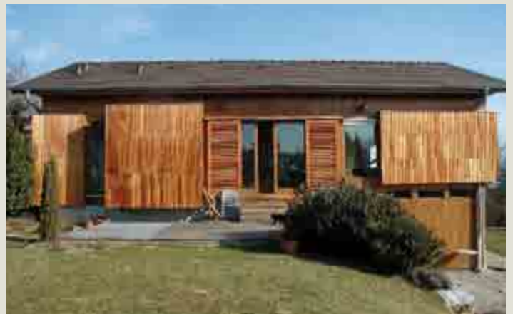
Accès haut et bas de plain-pied sur ce terrain pente.
