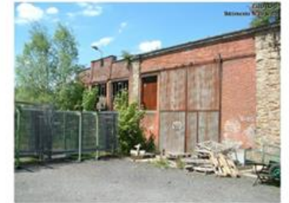
Les travaux entre 2017 et 2021
