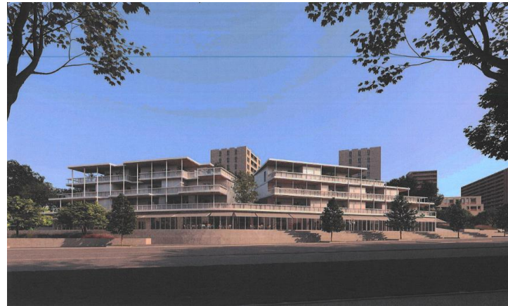
PISSEVIN – futur programme PORTE DES ARTS / STS : 22 Logements LLS et 1280 m 2 de commerces Aménageur : Ville de NIMES
