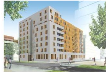
Lot E1 du projet « au fil de l'eau » réalisé par l'agence d'architecture Rue Royale @Lyon Confluence
