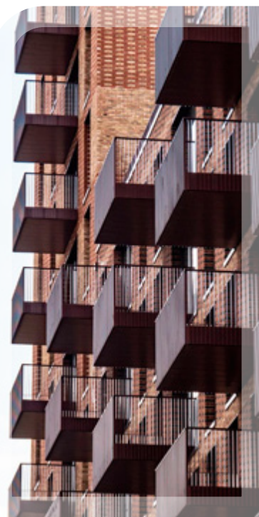
Balcons préfabriqués en hors-site (élément 3D non structurels). Les balcons sont souvent sources de litiges et concernés par les problématiques assurantielles.
