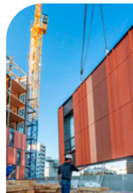
Façades préfabriquées hors-site en phase d'être posées sur chantier (©Les yeux carré TERREAL Magazine HORS SITE)
