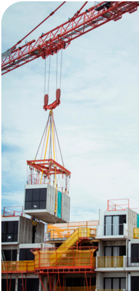
Composant préfabriqué (module 3D) pour pose sur chantier
