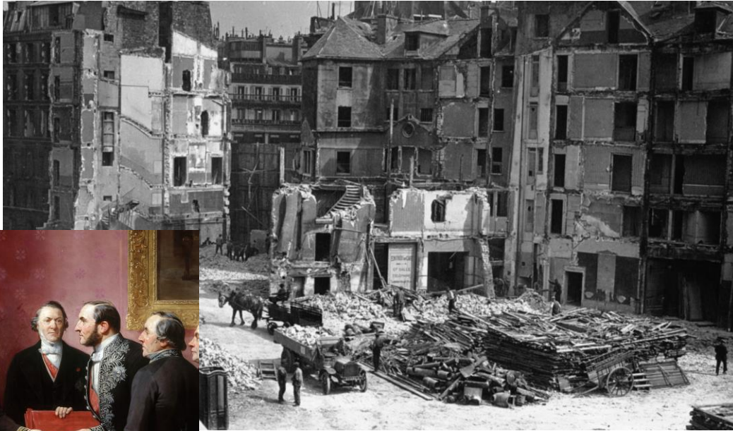
La fin des travaux (1920) du percement du bd Haussmann
