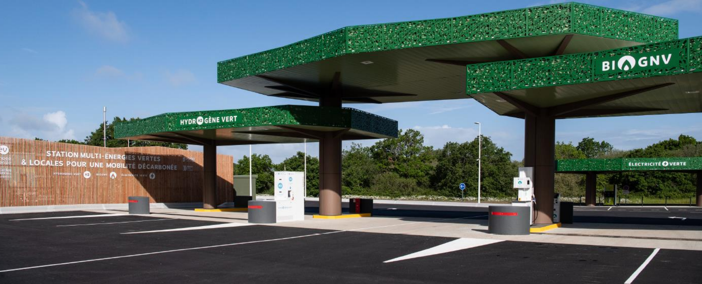
2 ème station multi-énergies vertes et locales aux Sables d'Olonne (MES avril 2023)
