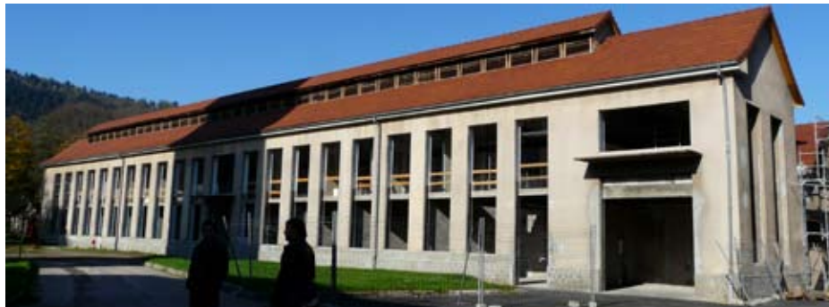
ateliers en cours de rénovation - 2008
