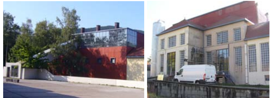
la grande chaufferie
