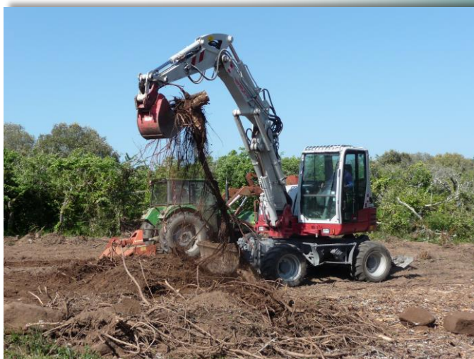
Dessouchage mécanique
