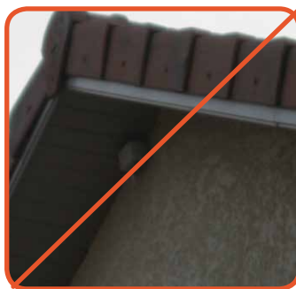
La sonde est dans un renforcement où la température est différente ; le rayonnement solaire est réfléchi par la toiture en-dessous
